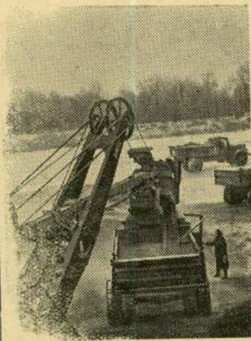
Удмуртская АССР. На строительстве Воткинской ГЭС ведутся подготовительные работы.
