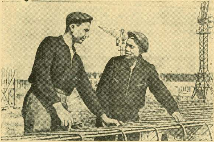
Свердловск. Недалеко от живописного озера Шарташ сооружается крупнейший завод железобетонных изделий. Комсомольцы дали слово построить этот завод на год раньше установленного срока. За успехи в социалистическом соревновании свердловской комсомольской стройке присуждено переходящее Красное знамя ЦК ВЛКСМ.
