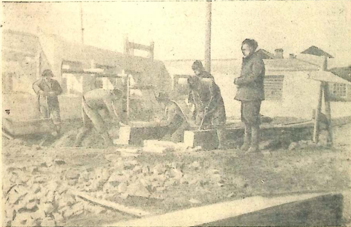
Большие строительные работы проводит райпромкомбинат. Все члены бригады, руководимой П. Бродягиным, систематически выполняют нормы выработки на 150 и более процентов.
