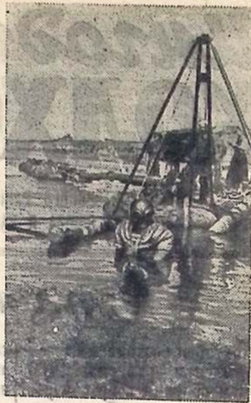
Омская область. Все дальше на Восток уходит магистральный трубопровод, сооружаемый между Омском и Новосибирском. На дне реки Омь трактором для труб роют водолазы.
